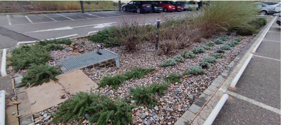
Área de biorretención (SUDS A1) en el Campus de Tudela de la Universidad Pública de Navarra (UPNA). Proyecto LIFE-IP NAdapta-CC LIFE 16 IPC/ES/000001.
