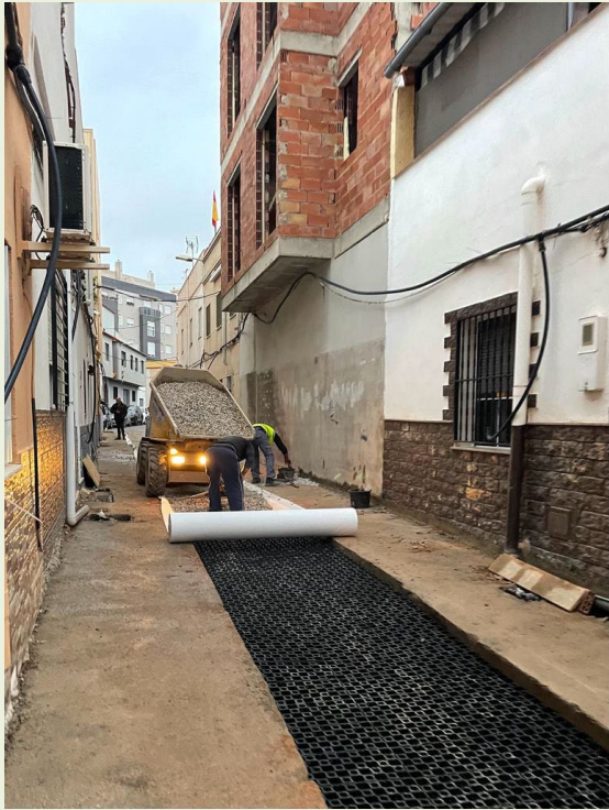
Instalación de pavimento permeable (SUDS) en un entorno urbano consolidado. Barrio Corell en Almassora (Castellón). Año 2022. Fuente: Eiffage Construcción.
