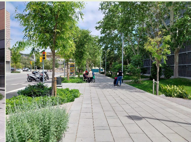
Cadena de SUDS: Pavimentos permeables, parterres inundables (jardines de lluvia y áreas de biorretención), alcorques con suelo estructural y carteles informativos sobre la gestión del agua de lluvia. Barrio del Bon Pastor en Barcelona. Fuente: Roberto Soto Fernández, «Instituto Municipal de Urbanismo, Ayuntamiento de Barcelona».
