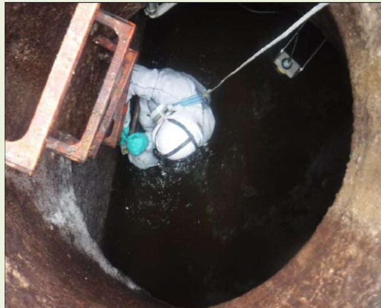
Inventario de la red de alcantarillado: conjunto de tareas para determinar la estructura y las características específicas de una red. Fuente: SOCADE.
