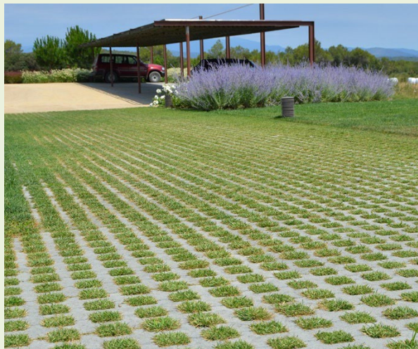
Pavimentos permeables (o drenantes). Ollers (Girona). Fuente: Breinco.
