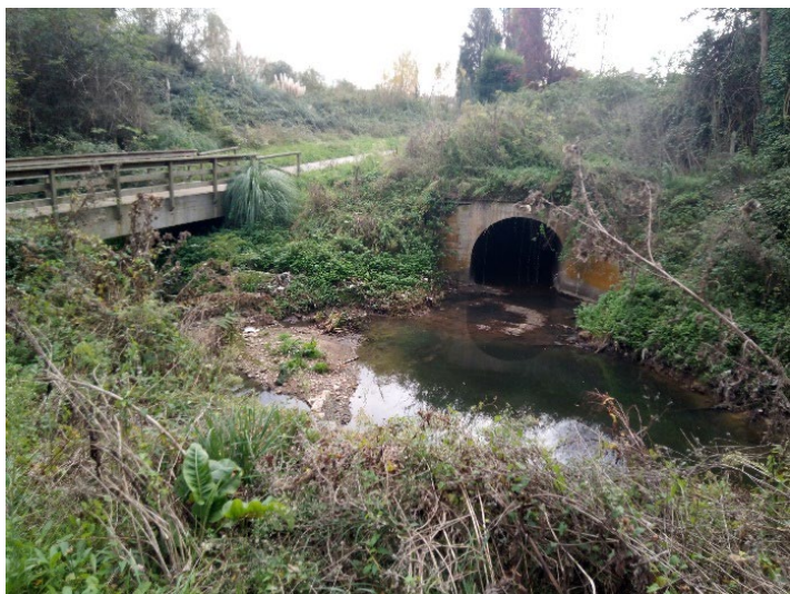
Punto de vertido del desbordamiento del sistema de saneamiento asociado a una Infraestructura de Regulación de Aguas Residuales (IRAR), Tanque de Tormentas, al DPH. España.
