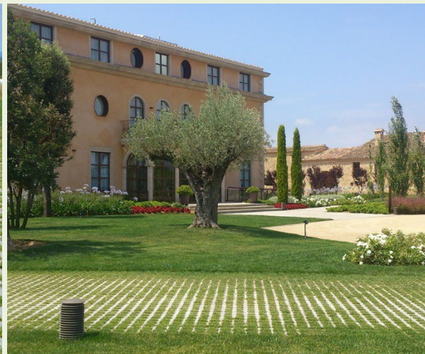
Pavimentos permeables (o drenantes). Ollers (Girona). Fuente: Breinco.
