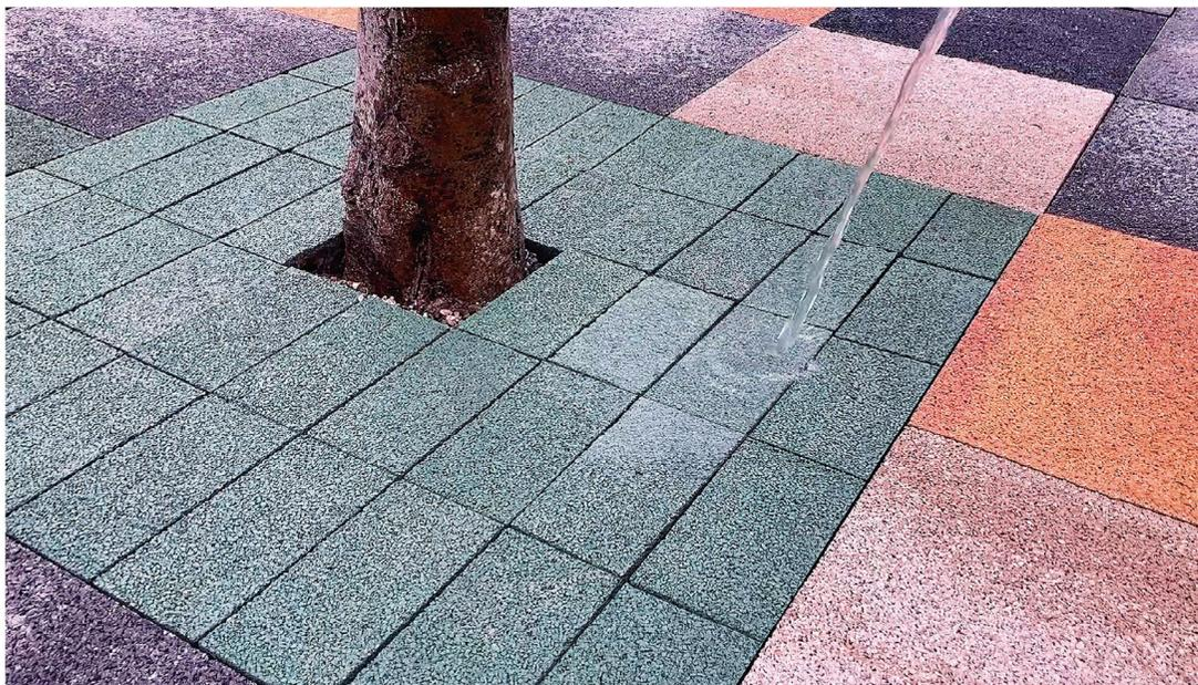
Figura 1. Alcorque con pavimentos drenantes ecoDraining
